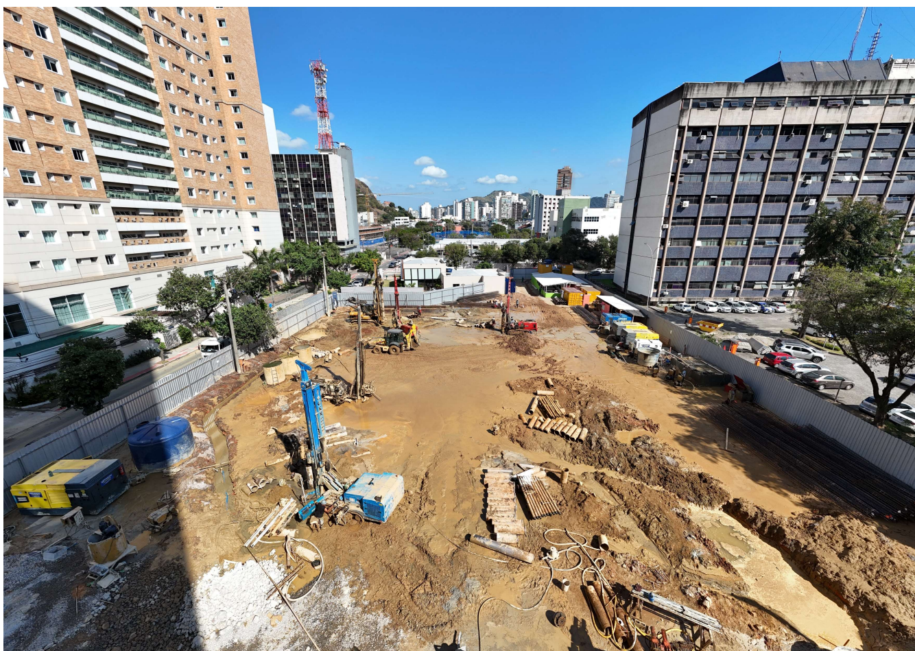
Execução do estaqueamento na área de projeção da torre.
