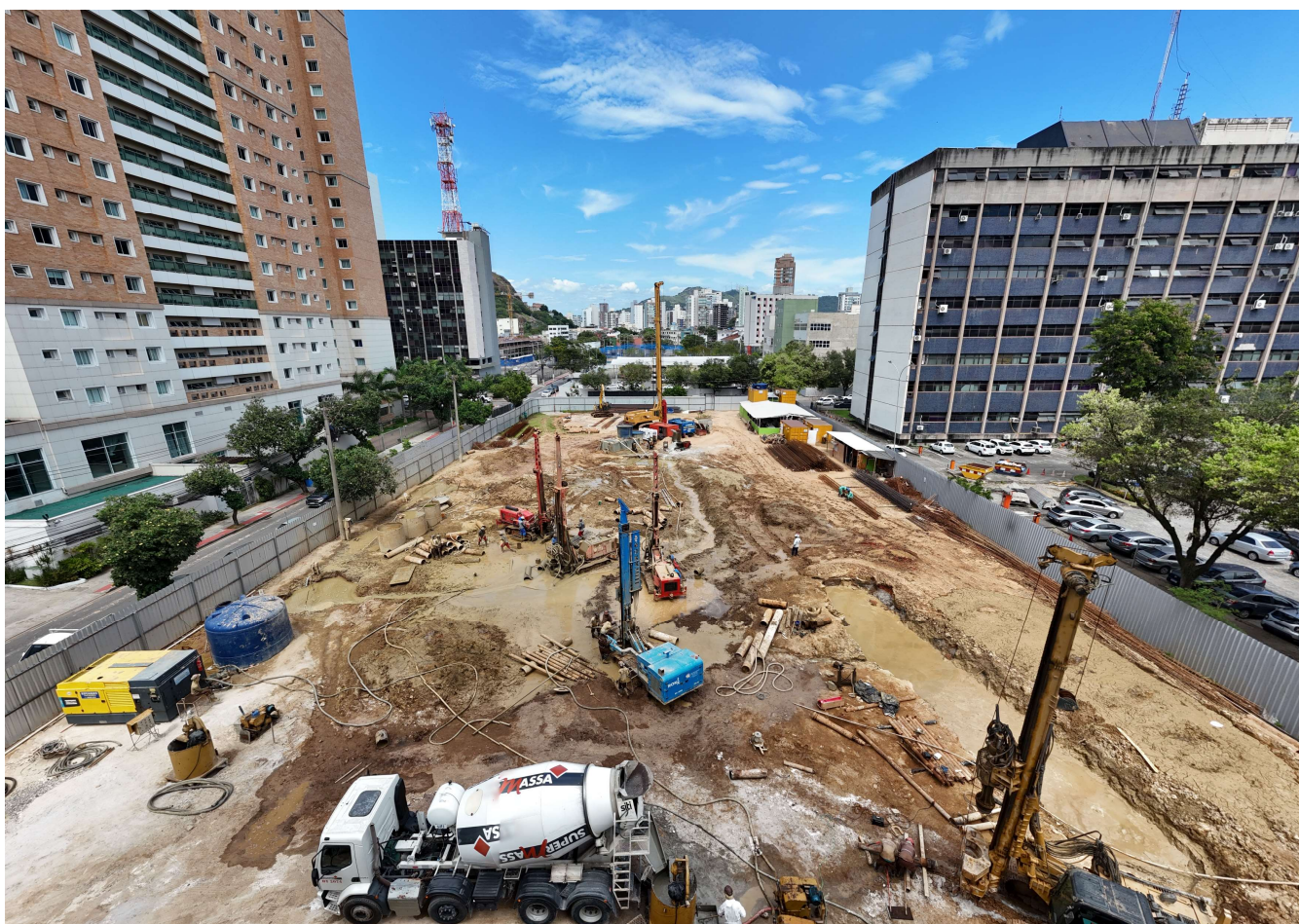
Execução das estacas na área de implantação da torre.
